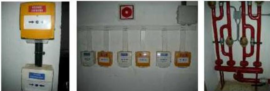
Los sistemas de rociadores automáticos disponen de electroválvulas que a través del sistema de detección de incendios ponen en carga las tuberías en caso de incendio. Manualmente se puede hacer girando la llave de paso que lleva incorporada.
